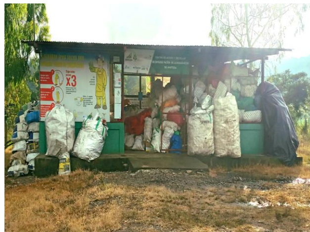
Anexo 12. Centro de acopio y reciclaje de envases vacíos de agroquímicos en Tomatoya, Jinotega.
