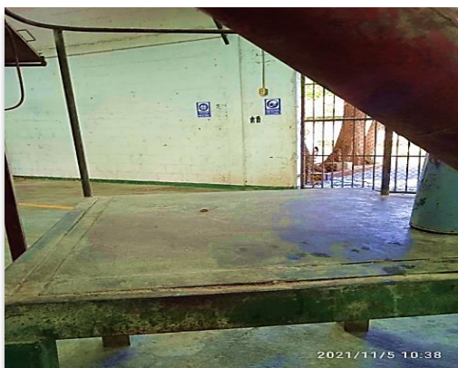
Figura 6. Paredes de la PEAB Fuente: propia
