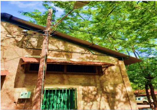
Figura 15. Iluminación de las áreas verdes Fuente: propia
