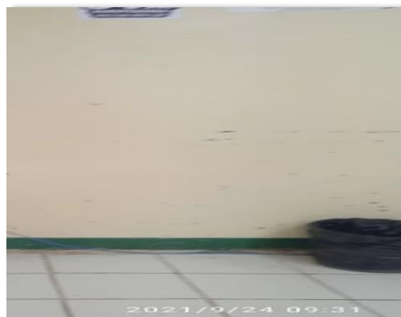
Figura 9. Paredes de la oficina Fuente: propia
