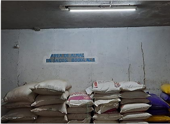
Figura 13. Iluminación de la bodega de almacenamiento Fuente: propia
