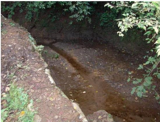
El ojo de agua cuenta con un diseño de infraestructura artesanal en forma de represa, con 13m de largo, 4m de ancho y 1.8m de profundidad (Figura 30), ayudando a mantener la preservación del agua y permitiendo que el drenaje continúe su curso de manera natural.
