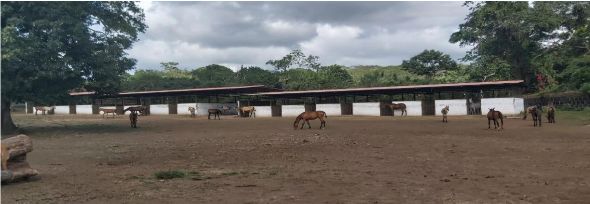
Anexo 19. Caballerizas con problemas de iluminación.
