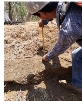
Anexo 13. Perdida de suelo por erosión y con teodolito presencia de toba.
