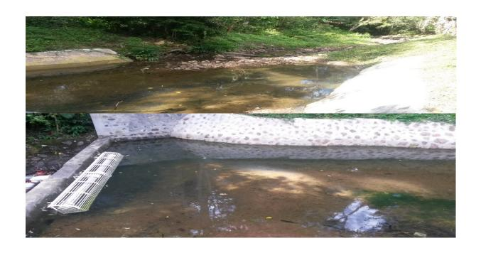
Figura 7. Captación abierta de fuente Santa Fe abastecedora del área urbana de La Dalia.
