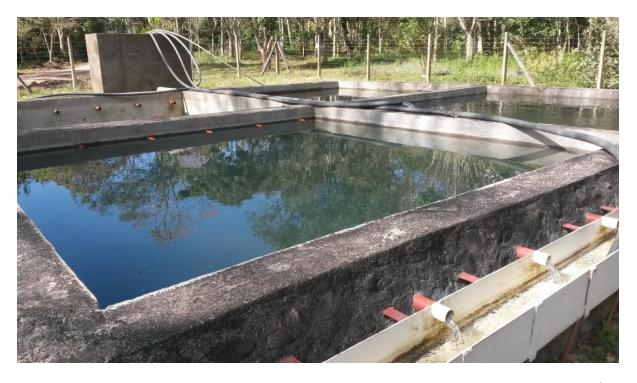
Figura 8. Pilas de almacenamiento abiertas de fuente Santa Fe abastecedora del área urbana de La Dalia
