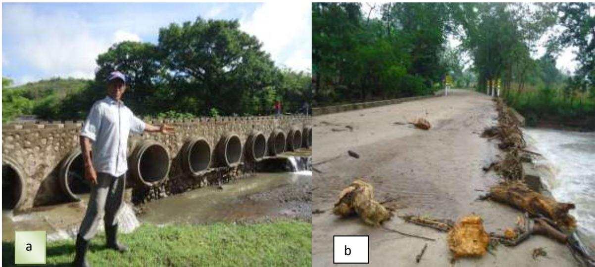
Figura 21. Daños parciales en las estructuras de puentes vados. a) En la comunidad Paso Hondo; b) Desbordamiento del río El Espinal en puente vado en la comunidad La Calera, producto del atascamiento de las boquillas, dejando sedimentos y trozos de madera en su recorrido.
