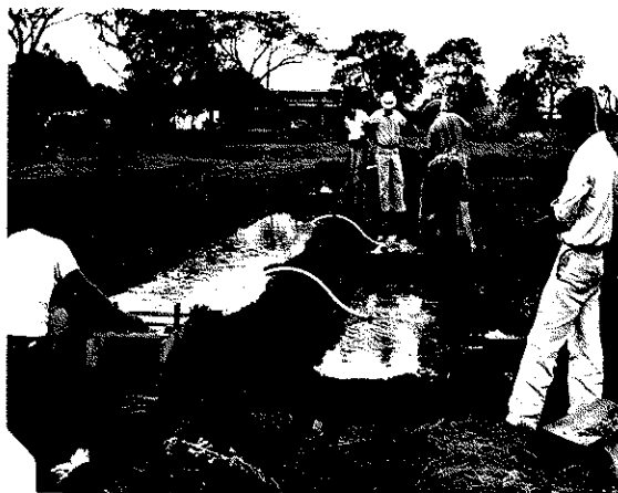
Fig. 6.- Compuertas manteniendo el tirante estático
