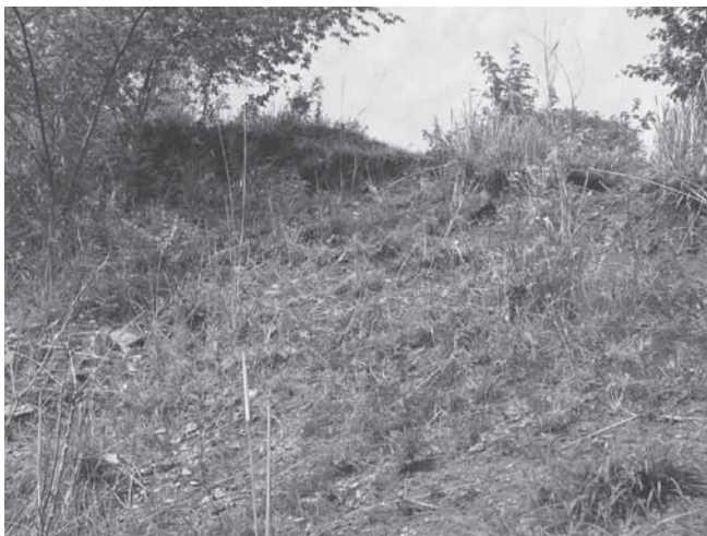
Figura 5. Deslizamiento en las vecindades de La Avellana.
