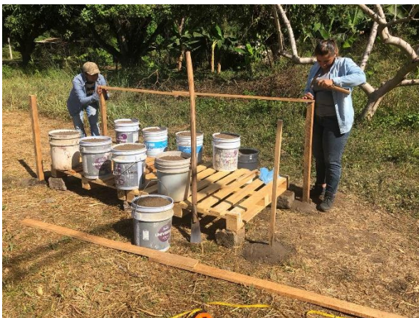
Anexo 10. Construcción del bloque lisimétrico
