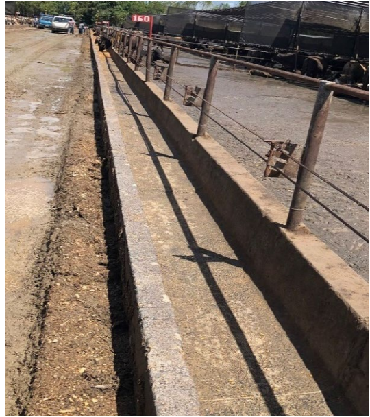
Imagen 31: Comedores en buen estado y estado lamido.
