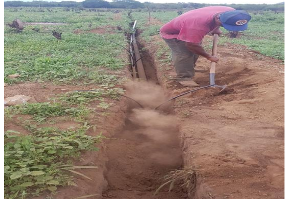
Figura 15. Tapado de zanjas
