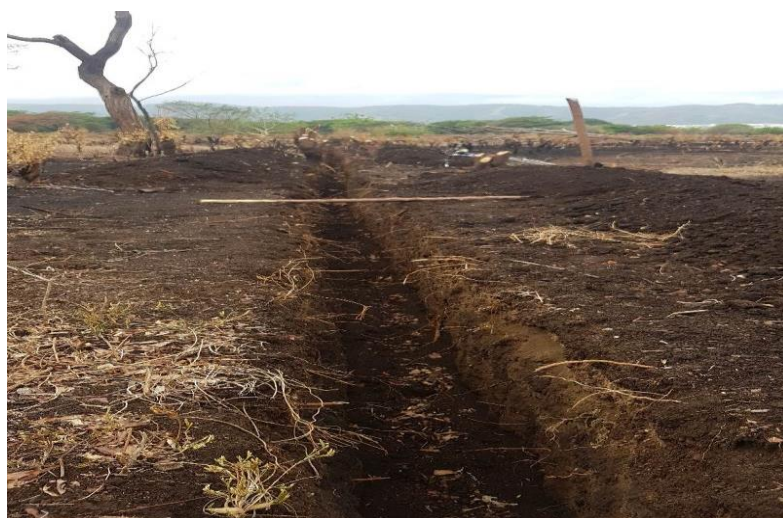
Figura 13. Zanjeo 60 cm de profundidad x 40 cm de ancho
