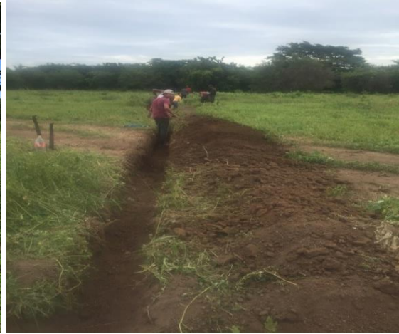
Anexo 17. Figura 10. Zanqueo para tubería de riego.
