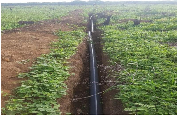
Figura 14. Tubería PVC SDR 26 presión 150 psi
