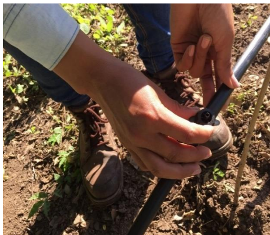
Figura 33. Colocación de goteros auto-compensados.
