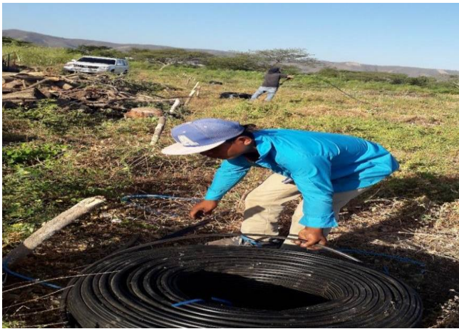
figura 16. Instalación de mangueras de polietileno de 16 m
