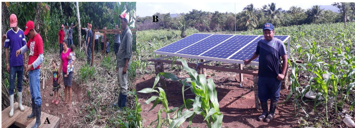
Figura 4. Construcción de pozos para sistemas de riego (A) Verificación de volumen de agua en el pozo (B) Verificación de instalación de paneles solares para riego
