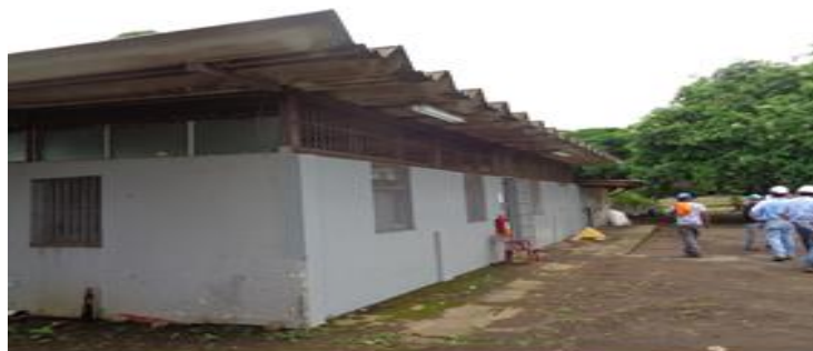
Figura 4. Láminas de nicalit a desinstalar.
