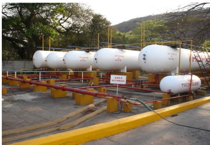
Figura 7. Tanques de GLP instalados iguales al que se pretende instalar en Tip-Top Industrial.
