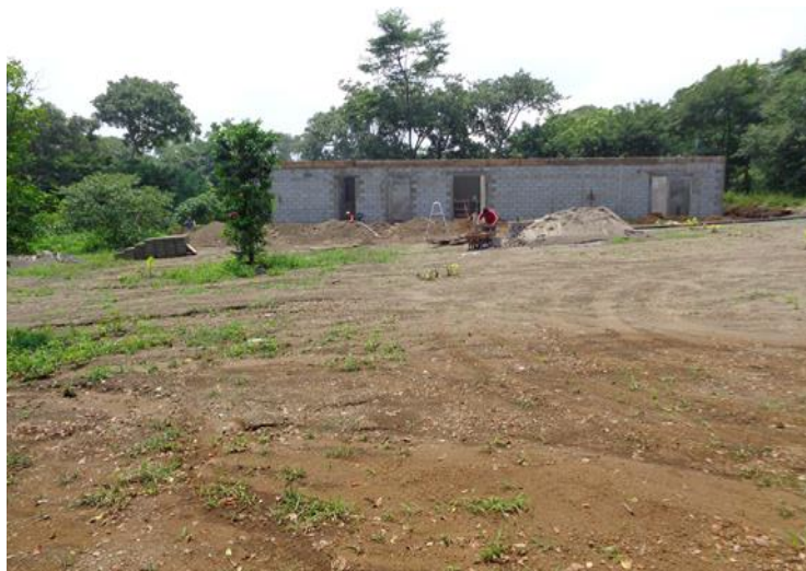
Figura 2. Avance de construcción de planta procesadora de mariscos “MAN KANG S.A”
