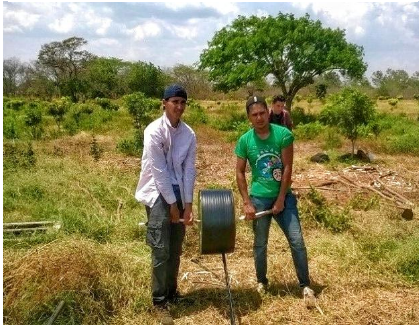
Anexo 6. Instalación del sistema de riego por goteo en la unidad experimental, finca El Plantel, Masaya 2017
