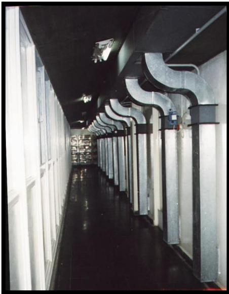
Figura 32. Extracción en zonas bajas de ventiladores
