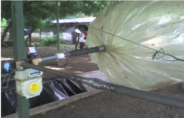
**g. Medidor de gas instalado en los biodigestores**
