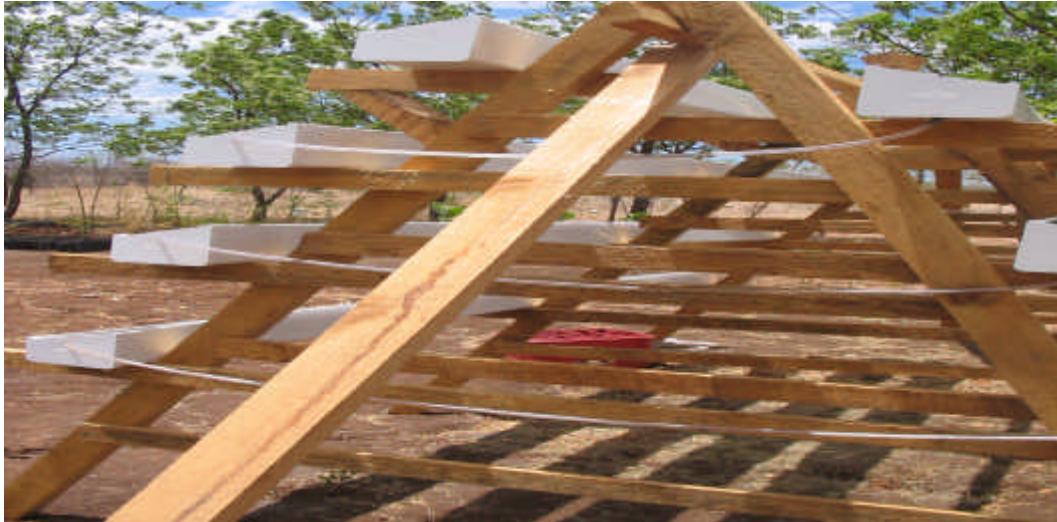
Foto 3. Conexión de las mangueras de desagüe. Pacora, San Francisco Libre. Managua, 2004.
