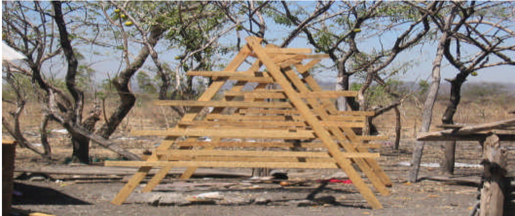
Foto 2. Estructura en forma de A . Pacora, San Francisco Libre. Managua, 2004.
