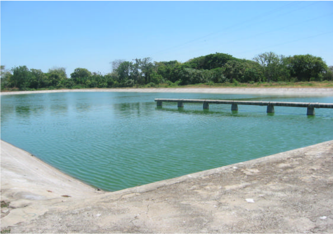
Foto 5. Pilas de tratamiento con aguas residuales estancadas.
