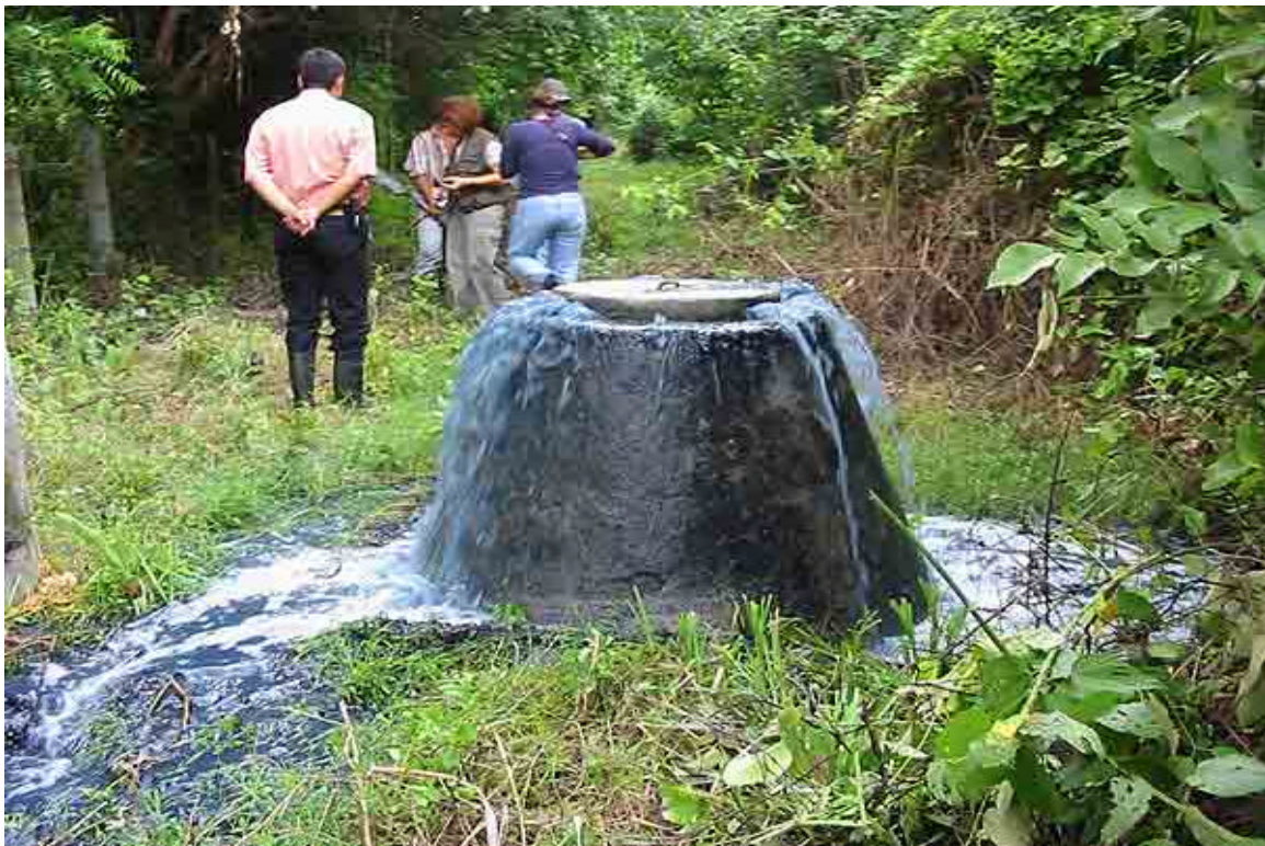
Foto 2. Derrame de aguas residuales industriales CIZFLM en los manjoles.
