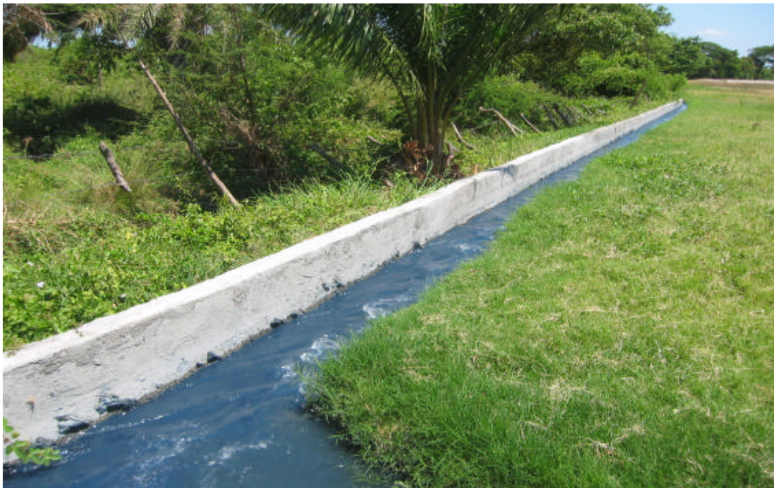
Foto 4. Caudal de las aguas residuales industriales y aguas domesticas proveniente de la CIZFLM con dirección al Lago de Managua.
