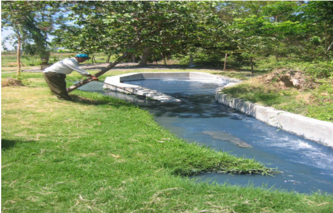
Foto 3. Punto donde convergen los dos tipos de agua proveniente de la CIZFLM con dirección al Lago de Managua.
