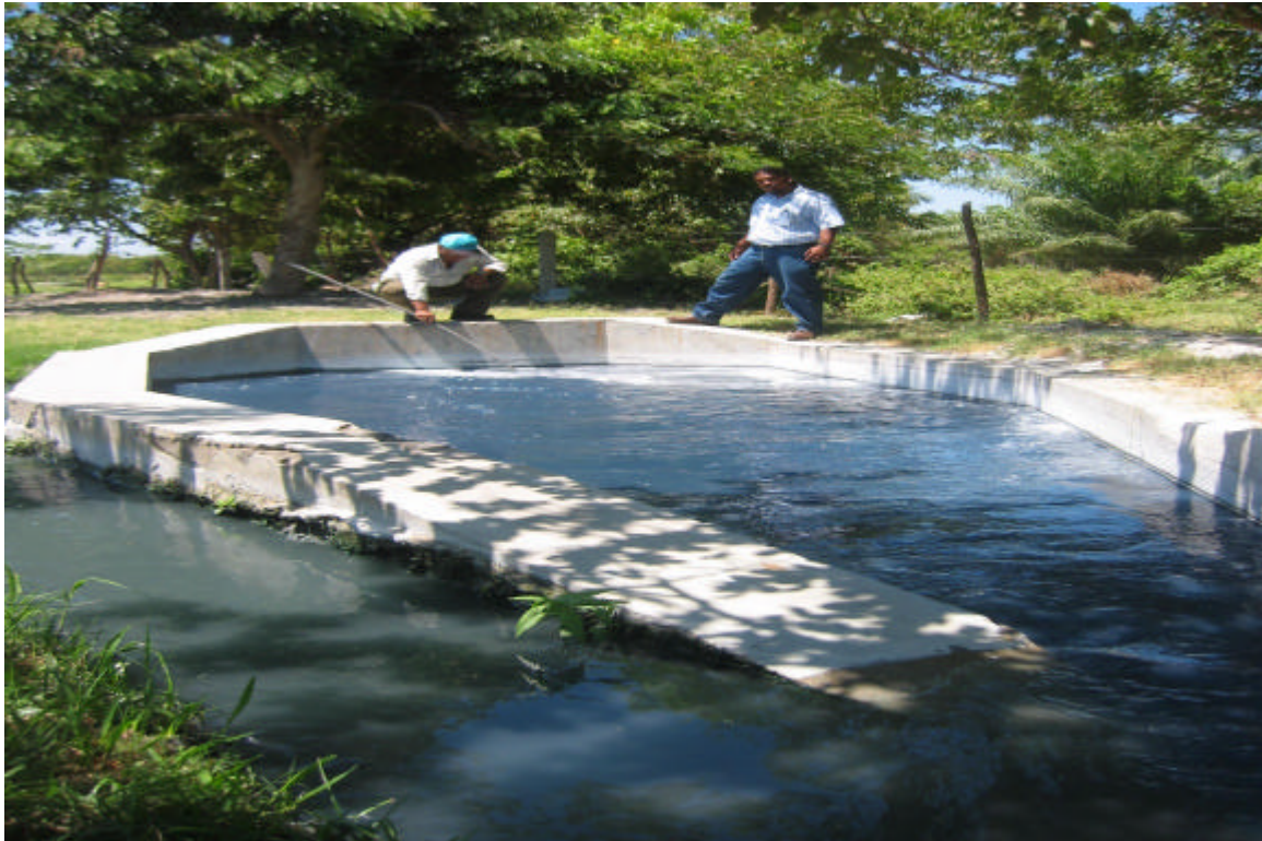
Foto 1. Salida principal de las aguas residuales industriales proveniente de la CIZFLM.
